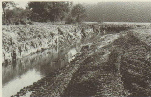
Renaturierung einer Waldlichtung mit ehemaligen Riesengräben während der Bauphase. Der Ringgraben ist auf der besucherzugänglichen Seite steilwandig.
